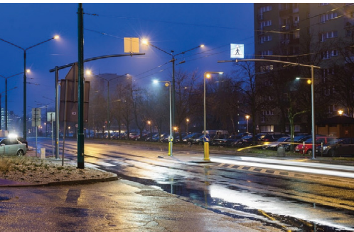
Wertykalne oświetlenie przejścia dla pieszych. Tychy, (fot. UM Tychy)
