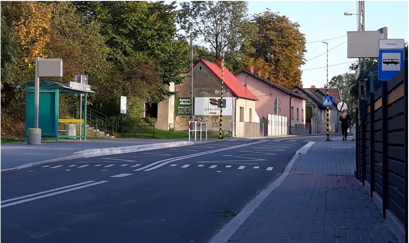
Rysunek 13 Przykładowy przystanek na wzór przystanku wiedeńskiego (Jaworzno Podwale) Źródło: opracowanie własne
