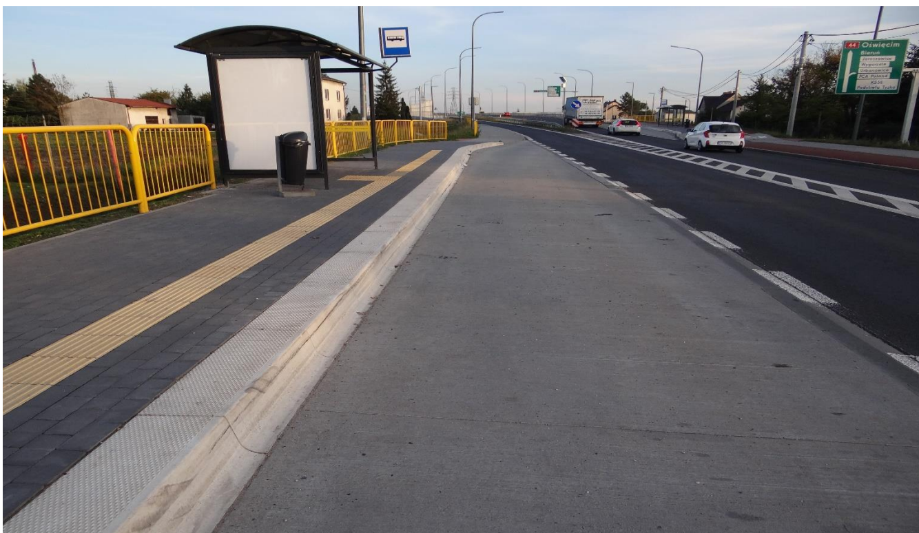
Rysunek 3 Zatoka autobusowa o nawierzchni betonowej na przystanku Tychy Urbanowice Źródło: opracowanie własne
